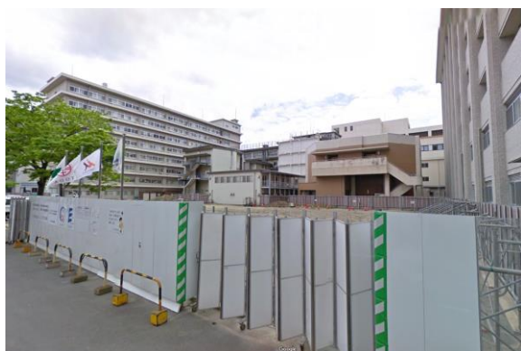
図 1 Google ストリートビューで公開されている 蔵本キャンパスの工事中の写真
